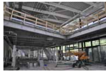
Verbundbau und Stahlbau im Rohbau © osd GmbH & Co. KG
