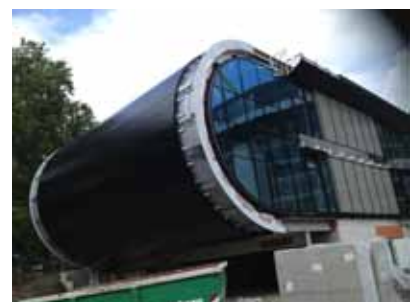
Fassade Rundung in Montage © msm meyer schmitz-morkramer gmbh
