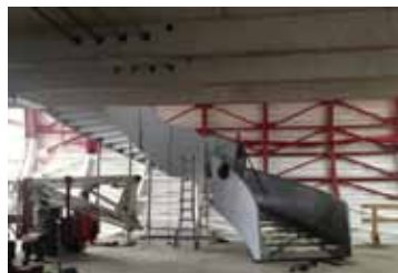
Stahlterrace und Rundung im Rohbau.jpg © osd GmbH & Co. KG
