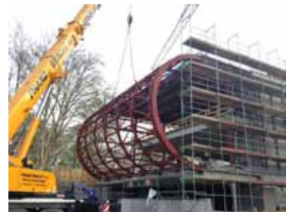
Montage Rundung © osd GmbH & Co. KG
