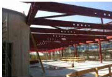
Stahldach Rohbau © osd GmbH & Co. KG
