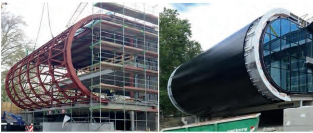
**Das Fassadentragwerk der runden Westfassade wurde im Werk vorgefertigt und als ein Teil auf der Baustelle montiert und mit Unterkonstruktion, Dämmung und Bekleidung komplettiert. Hier fehlen noch die seitlichen Anschlüsse sowie die Übergänge zu den Nord- und Südfassaden**
